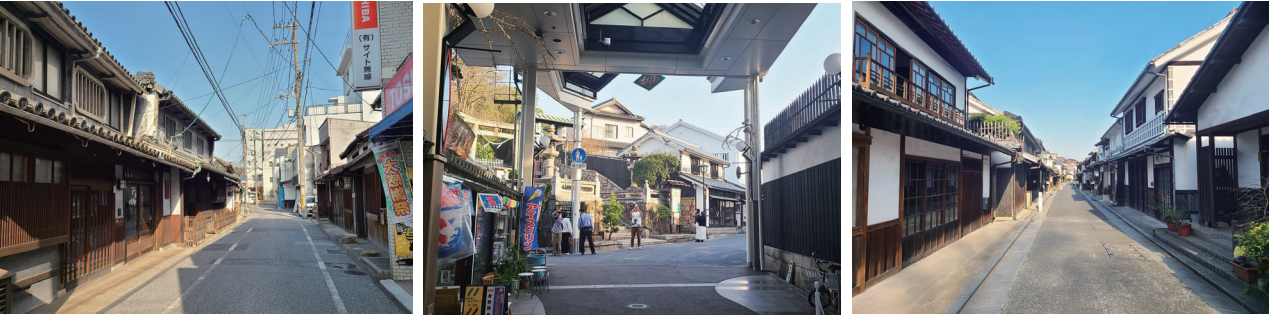
① 阿知3丁目 ② えびす商店街付近 ③ 東町 ④ 美術館・図書館・自然史博物館エリア ⑤ 倉敷川 ⑥ 本栄寺からの本葺きの藁の町並み
